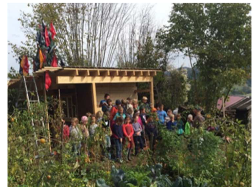
Lehm stampfen für die Ziegel, Mauern der ersten Steine, Richtfest
